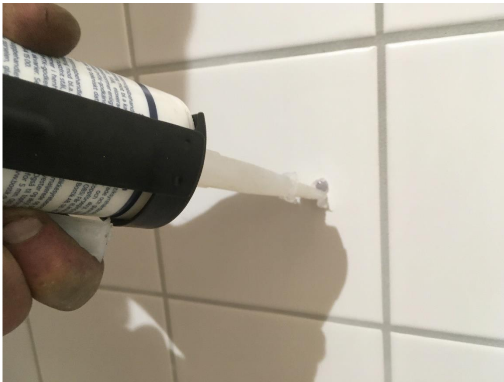
7. Under uppbyggnad. För-borrade hål i kakelplatta tätas med Silicon.
