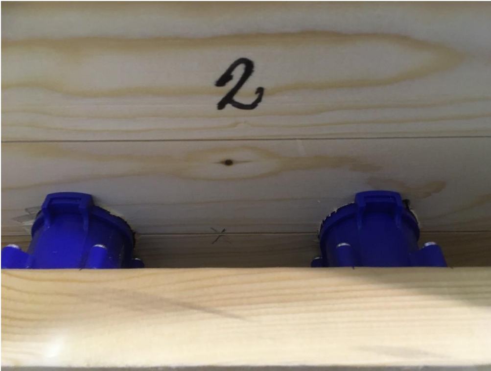
4. Under uppbyggnad. Duschblandare boxar mot kortling. Bild från baksida.
