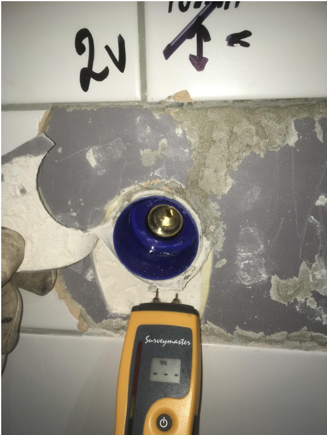
17. Kontroll. Inga läckage detekterade efter avslutad provning.
