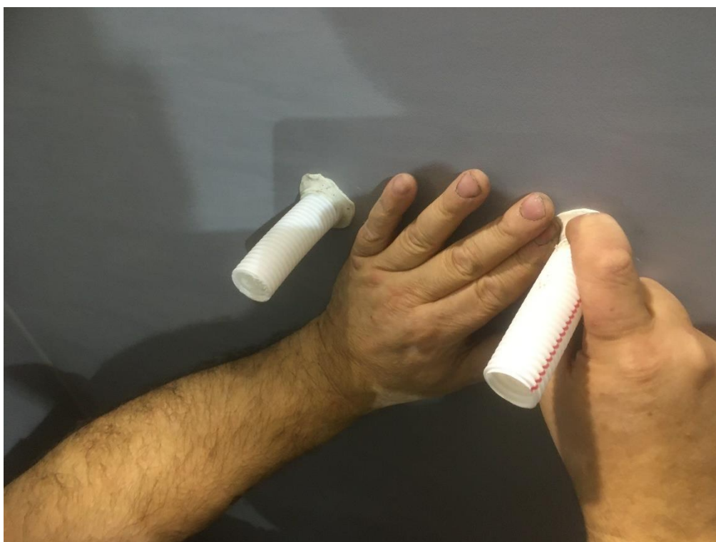
3. Under uppbyggnad. Tätning av genomföring.
