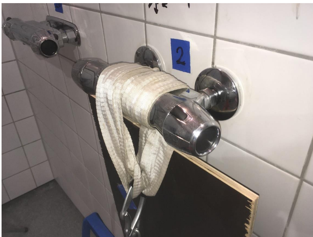
11. Pågående provning. Belastning med statisk last.
